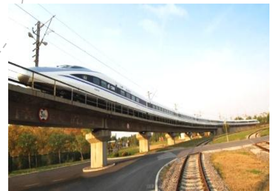
Prueba de línea
